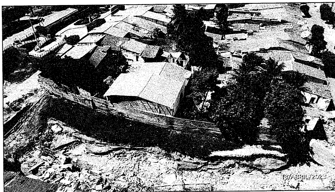
Figura 4 – Danos em nas residências em áreas de risco.
