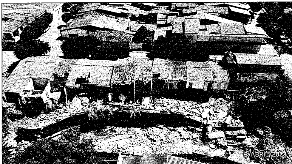
Figura 1 – Danos em nas residências em áreas de risco.
