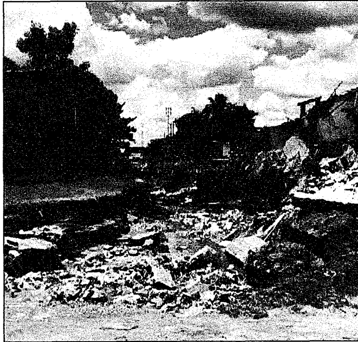
Figura 5 – Danos em nas residências em áreas de risco.
