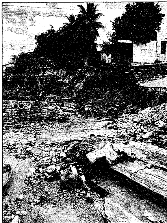
Figura 6 – Danos em nas residências em áreas de risco.
