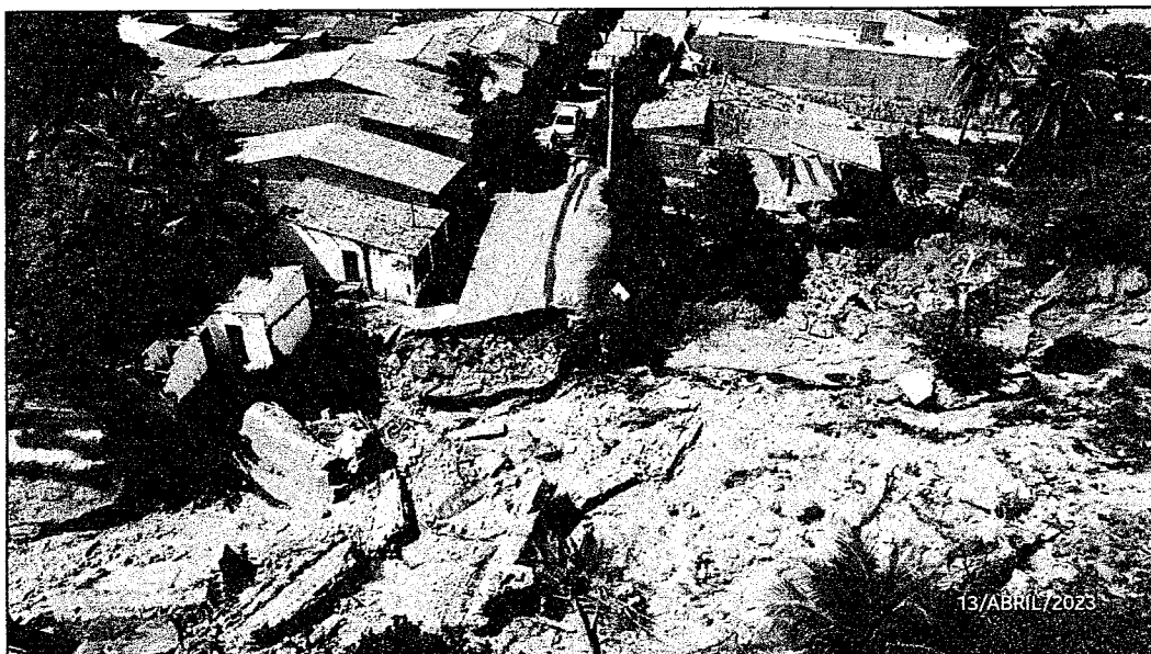
Figura 7 – Passagem molhada destruída na Rua João Pires.
