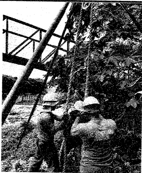
Execução da sondagem 1 - amostra predominante no local ( Argila cinza )
