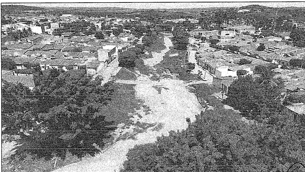
Figura 11 – Calha larga do Rio Oitis, com largura de 30 metros, onde não foram detectados danos.
