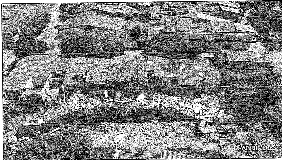
Figura 3 – Danos em nas residências em áreas de risco.
