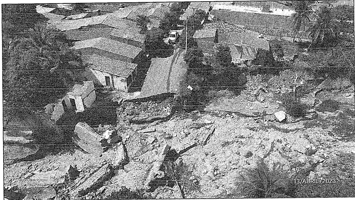
Figura 5 – Danos em nas residências em áreas de risco.
