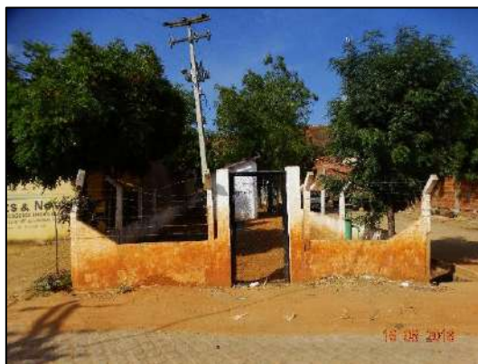
Imagem 2 – Estrutura de captação subterrânea cadastrada no município de Porteiras
